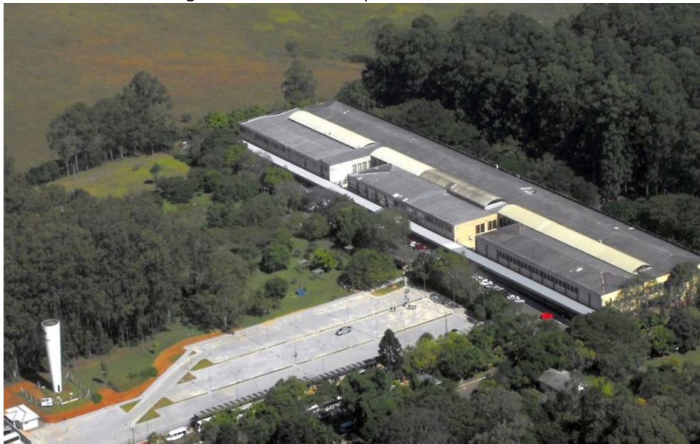
Figura 3 - Vista aérea do prédio no ano de 2018
